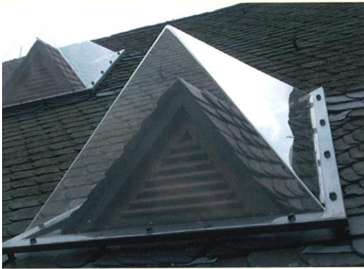
Luftkollektoren über den Dreiecksgauben der Süddachfläche
