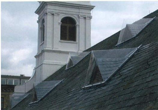
Luftkollektoren über den Dreiecksgauben der Süddachfläche
