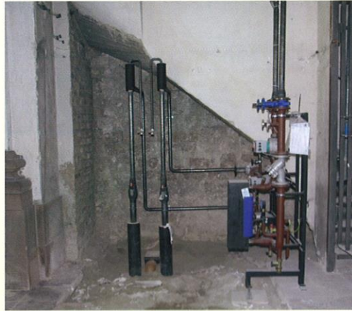
4 Fernwärmeübergabe unter der Empore
